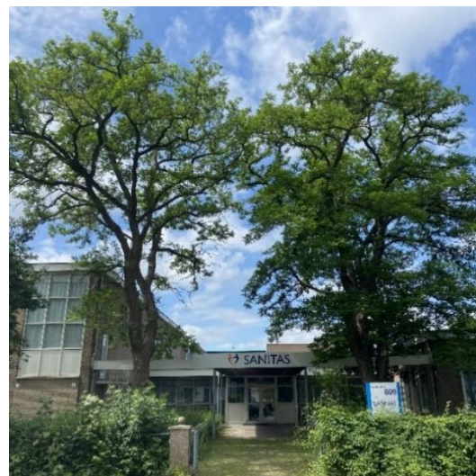
Afbeelding: gebouw Livingstonelaan 609
